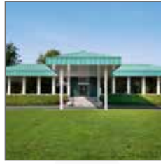
Woco Industrietechnik GmbH Bad Soden-Salmünster Bad Soden-Salmünster (Deutschland)
