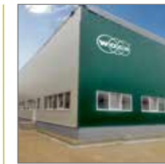
Woco Pipe System Components Rom SRL Satu Mare (Rumänien)
